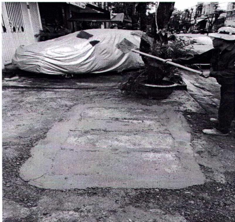
*Hình ảnh sau xử lý tại vị trí nắp cống vỡ tại 49 Lê Tấn Trung*
