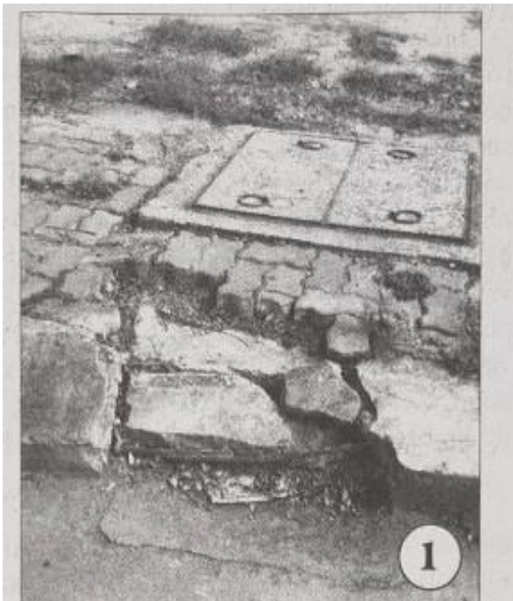
Hình ảnh trước và sau xử lý đầm bó vỉa tại góc đường Đức Lợi 3 – Như Nguyệt
