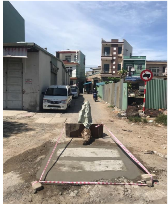
Hình ảnh trước và sau xử lý tại vị trí hố ga bị vỡ đường Nguyễn Tất Thành
