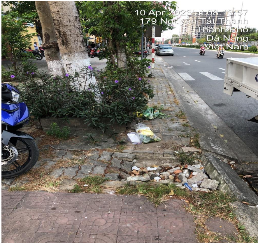
Hình ảnh hố ga bị sụt lún trước xử lý trên vỉa hè đường Nguyễn Tất Thành
