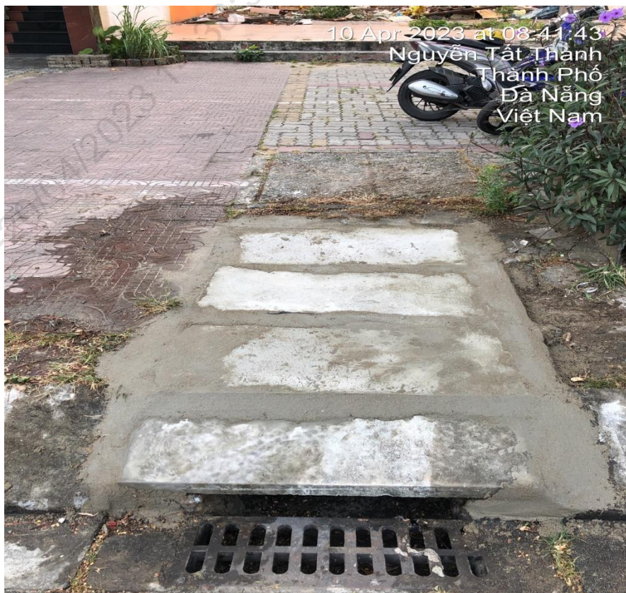
Hình ảnh hố ga bị sụt lún trước xử lý trên vỉa hè đường Nguyễn Tất Thành
