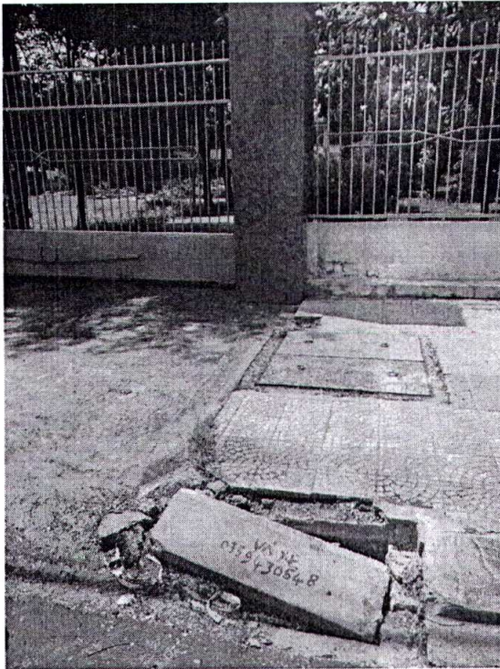
Hình ảnh trước và sau xử lý vị trí bó vỉa xô lệch trên đường Nguyễn Công Trứ
