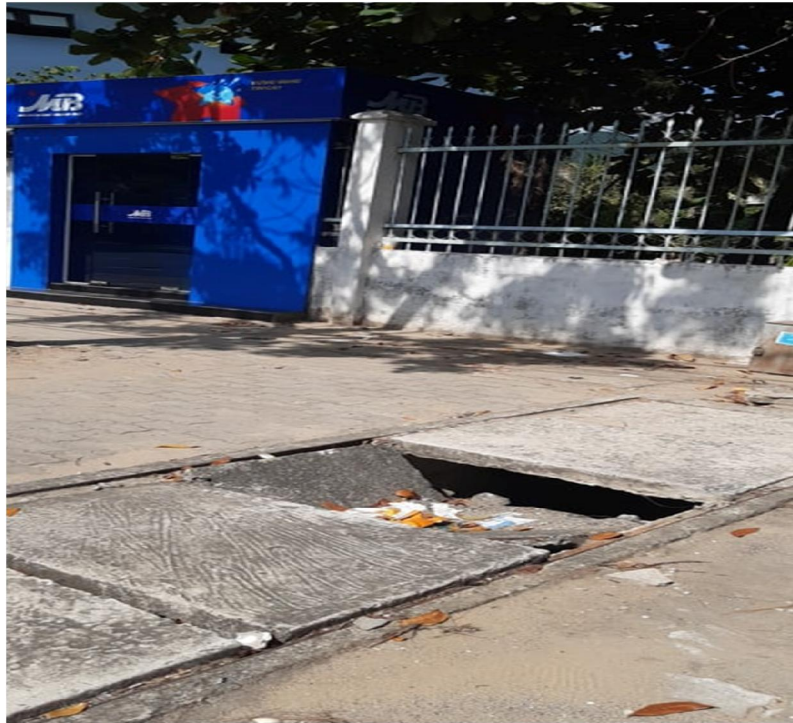
Hình ảnh trước xử lý tình trạng cống nghẽn nhà số 02 Y tế Kiều
