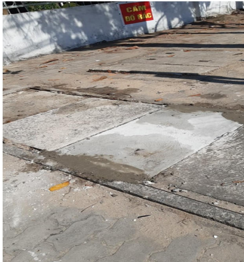
Hình ảnh sau xử lý tình trạng cống nghẽn nhà số 02 Y tế Kiều
