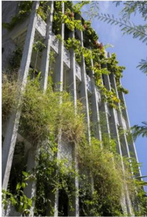
Hình 6.2.4: Văn phòng hiện đại, Đà Nẵng | The Modern Office, Danang Source: Ho Khue Architects
